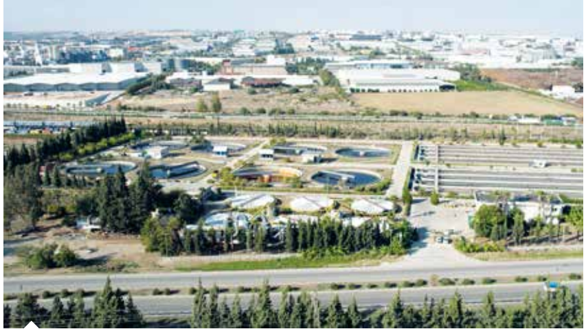
Adana Hacı Sabancı Organize Sanayi Bölgesi’nde, Avrupa standartlarında işletilen atık su arıtma tesisi 2013 yılında “Çevre Dostu Sanayi Ödülü”ne layık görüldü.
